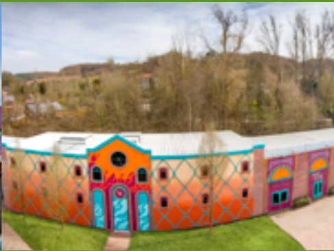
Extérieur bâtiment Psyké Underground Walibi Belgium.
